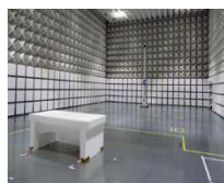
10m法電波暗室
